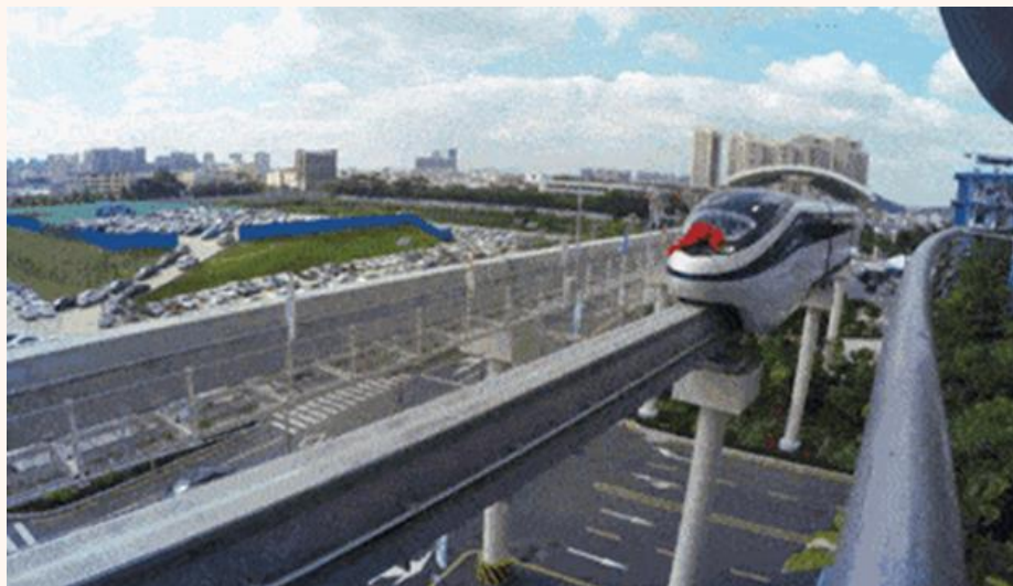
轨道交通建设
