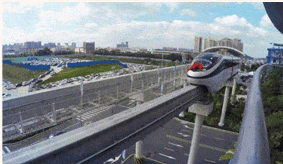
轨道交通建设
