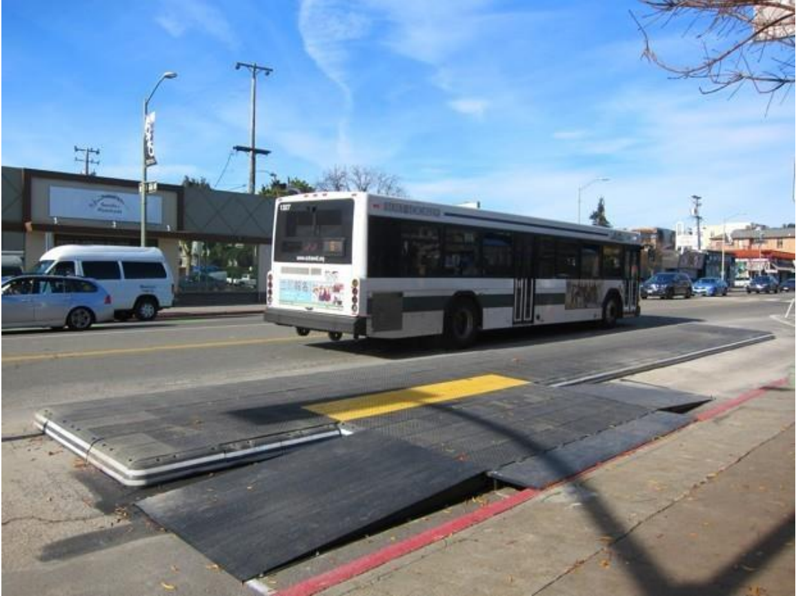
图二、年初在奥克兰和加利福尼亚组装的简易巴士岛。在公交车的行驶速度不被影响的前提下，让骑行者可以在自行车道上安全骑行。图：Zicla
