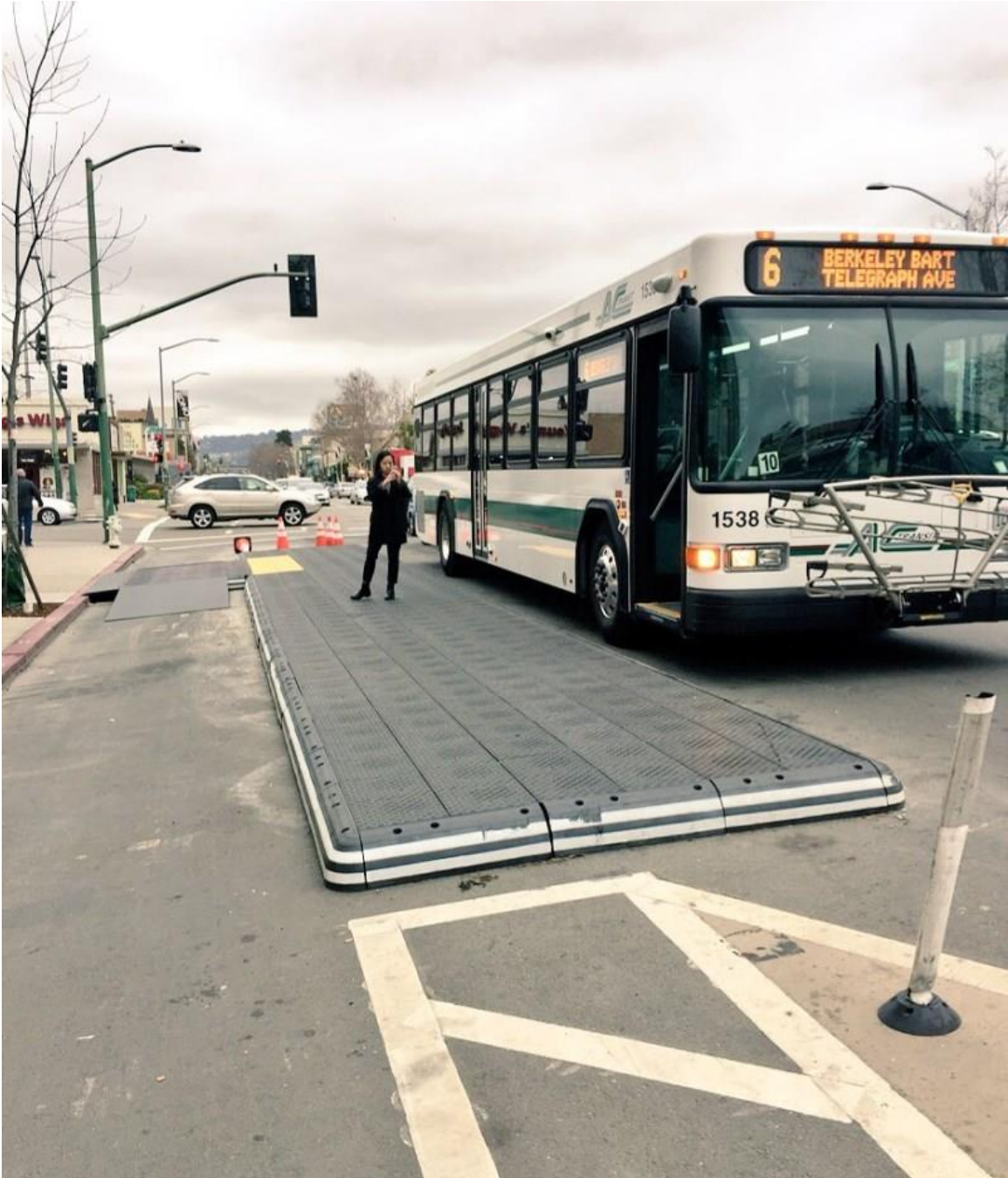
图三、奥克兰使用塑料模块在 Telegraph 街道搭建了一个公交车站。 图片: TransitCenter
