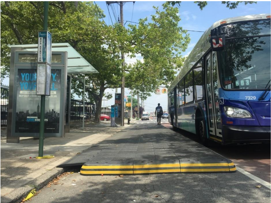
图一、在布鲁克林公交站，凸形公交站的预制装置在取得成功之后已经被拆除。不久之后，在原来预设装置的地方将会建造混凝土凸形公交站。图：TransitCenter
